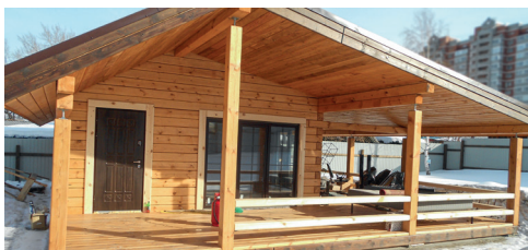
ОТОПЛЕНИЕ ДОМА ИЗ БРУСА, вид на объект
